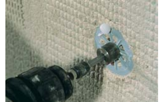
Установка крепежа сквозь армировочную сетку
